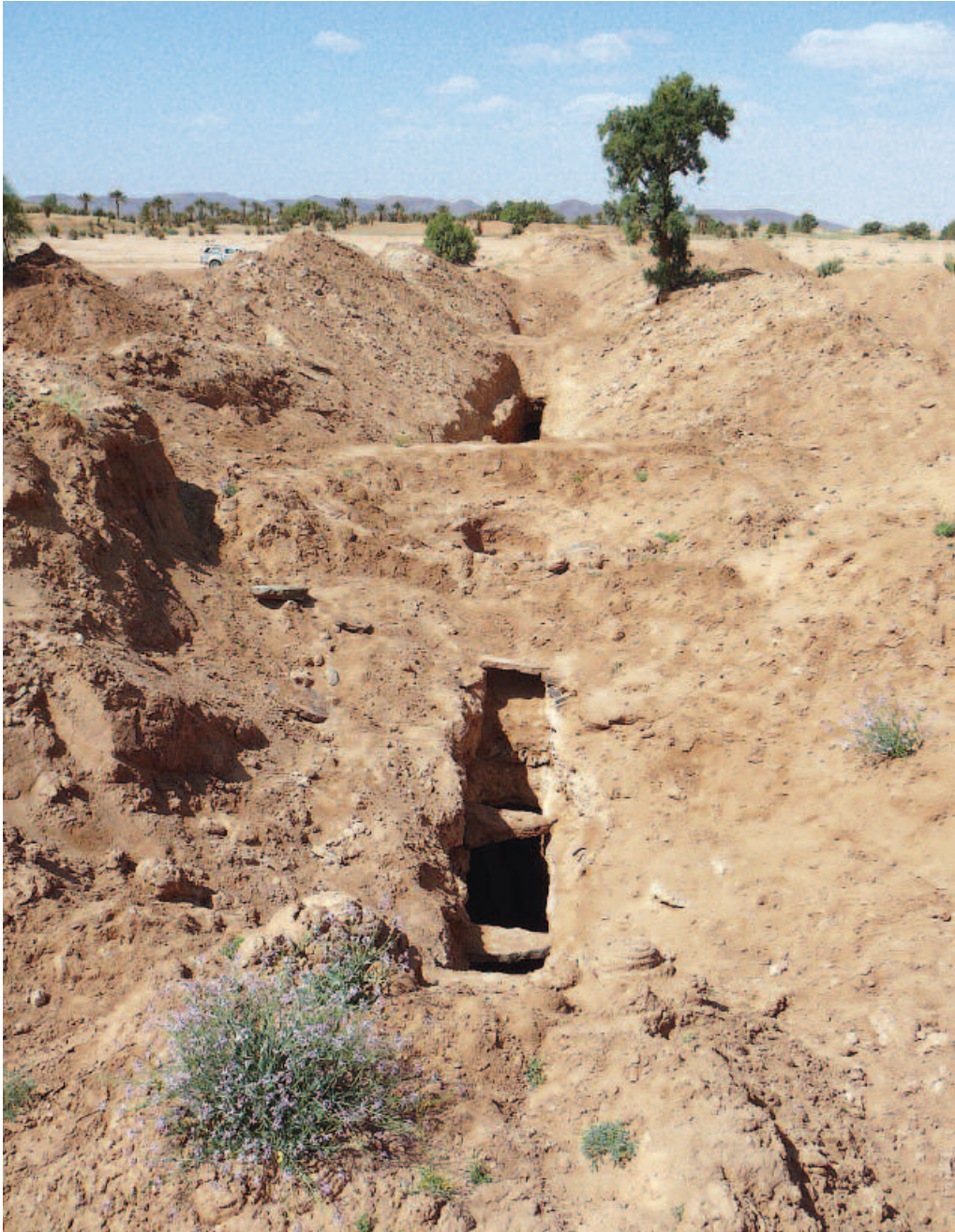
La khattara Lambarkia (Jorf-Mankara, Tafilalet, Maroc) est dégagée après les crues de l'automne 2006 qui s'étaient déversées à l'intérieur de la galerie, provoquant des effondrements de la voûte sur plusieurs centaines de mètres.
